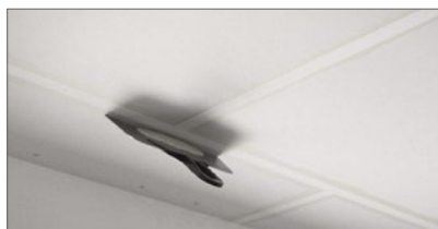
Påfør Rockfon Mono Acoustic Powder Filler på tapen og fyld samlingerne med filler.
