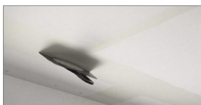
Når første lag er tørt, påføres et lag Rockfon Mono Acoustic Powder Filler (anvend 240 mm spartel).
