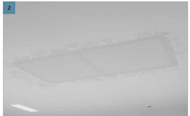
2 Tilskær et pladestykke af en ny Rockfon Mono Acoustic plade og sæt pladestykket fast i hullet ved hjælp af filler.
