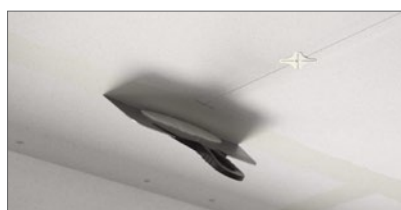
Påfør et tyndt lag af Rockfon Mono Acoustic Ready-Mix Filler på samlinger og rundbeslag (anvend 160 mm spartel).
