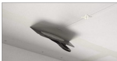
Påfør et tyndt lag af Rockfon Mono Acoustic Powder Filler på samlinger og rundbeslag (anvend 160 mm spartel).
