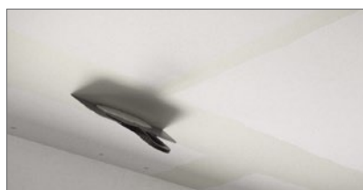
Når første lag er tørt, påføres endnu et lag Rockfon Mono Acoustic Ready-Mix Filler (anvend 240 mm spartel).
